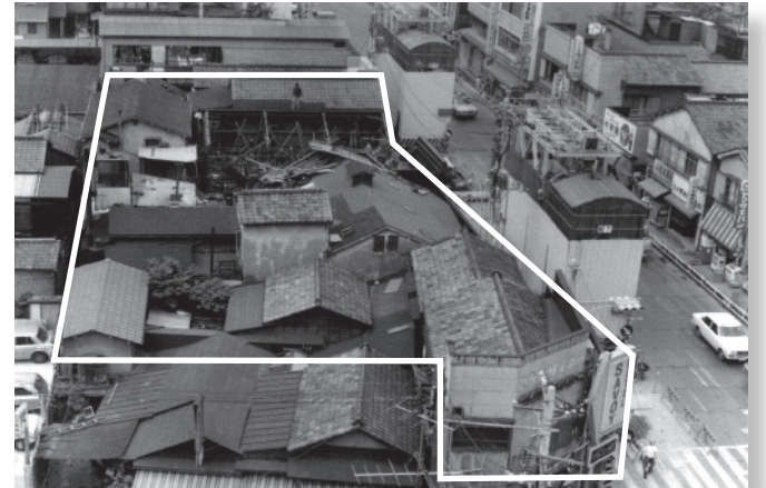
赤坂時代の工場の最後の全景。白線内が敷地。工場の解体が始まったところで、母屋がすでに壊されている。地下鉄千代田線工事の橋が道路上に建っている
